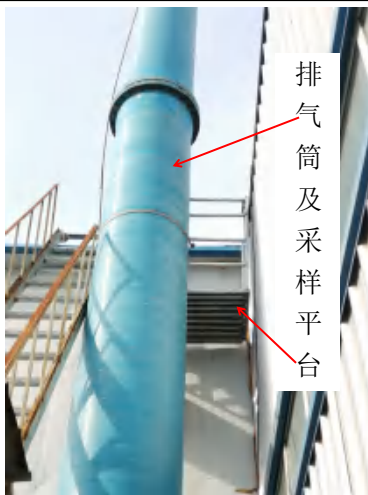
单色 940 印刷机废气收集措施
